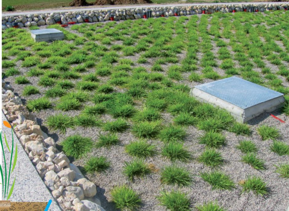
Sopra. In primo piano: particolare di una delle due vasche di fitodepurazione verticale in funzione presso la Fintessile
